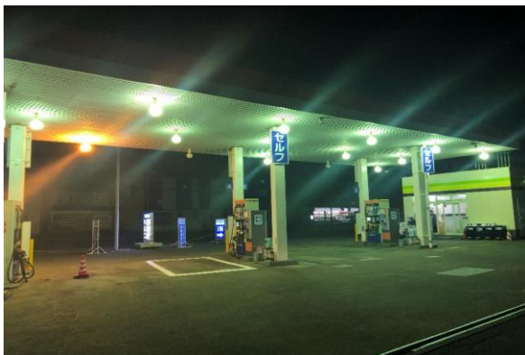
施工前 225lx (水銀灯360W 計26台使用)
