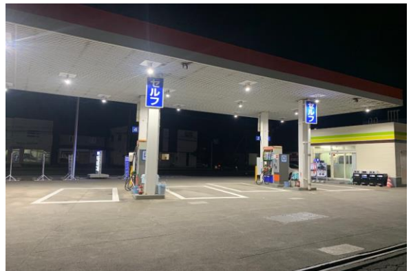
施工後 518lx (LED100W 計26台使用)
